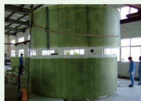
■ 外部 FRP 缠绕焊接
