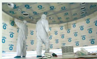
■ 内部板材焊接
